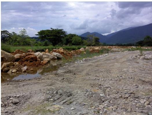
**Foto 5** Vista en detalle donde se observa la proximidad del material sobrante de excavación con respecto al flujo de agua que discurre por el río pamplonita
